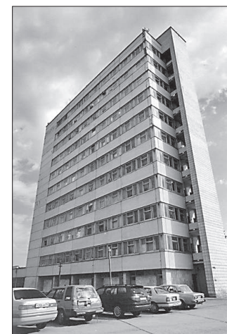
Здание СКТБ МК
