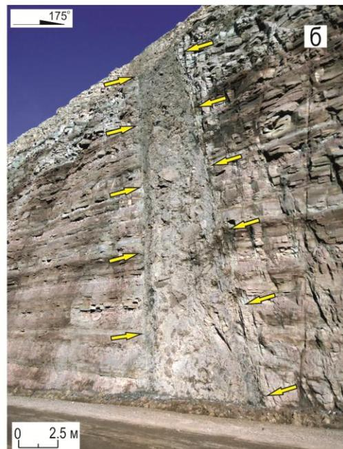
Рисунок 25. Выходы нарушений Широтного разлома в бортах карьера «Нюрбинский» (фото автора). а – зона повышенной трещиноватости и дробления по центральному сместителю, горизонт + 100 абс. м.; б – зона дробления по осевой линии южного сместителя, горизонт + 55 абс. м.
