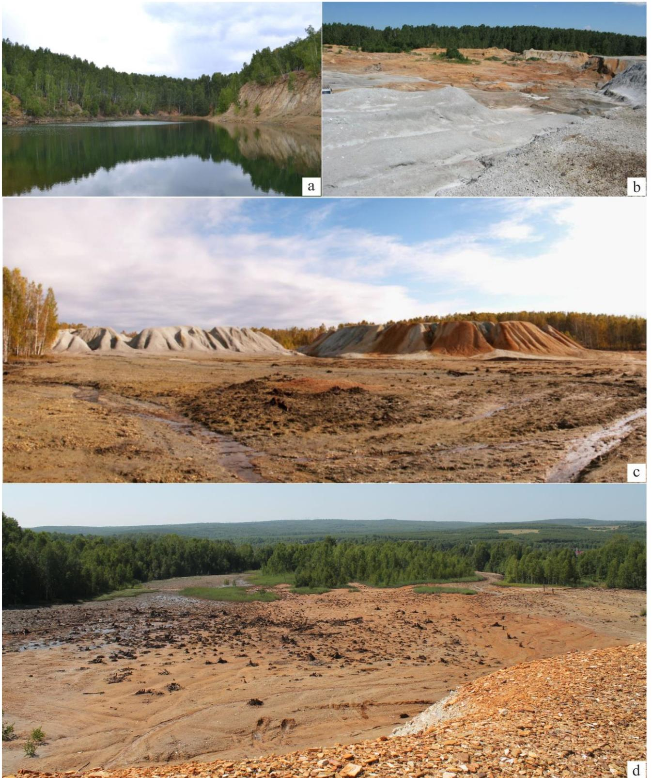
Рисунок 2.2. Фотографии Урского хвостохранилища: а – вид на затопленный карьер; б – вид на породный отвал; с – вид на отвалы отходов первичных руд (слева) и отходов руд зоны окисления (справа); d – вид на заболоченный лог и поток рассеяния с отвалов отходов руд зоны окисления.
