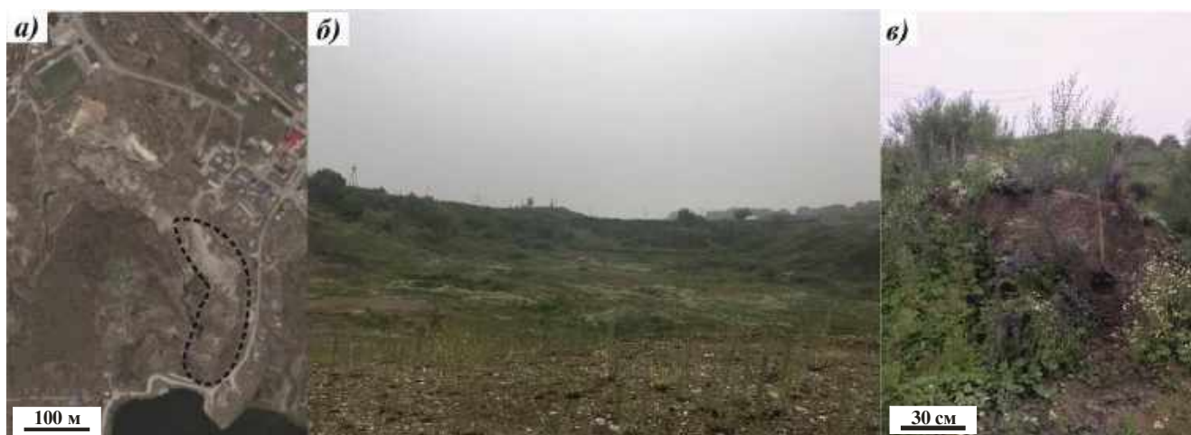
Рисунок 9. Змеиногорское хвостохранилище: а) космоснимок; б) общий вид; в) насыпь ТМО.
