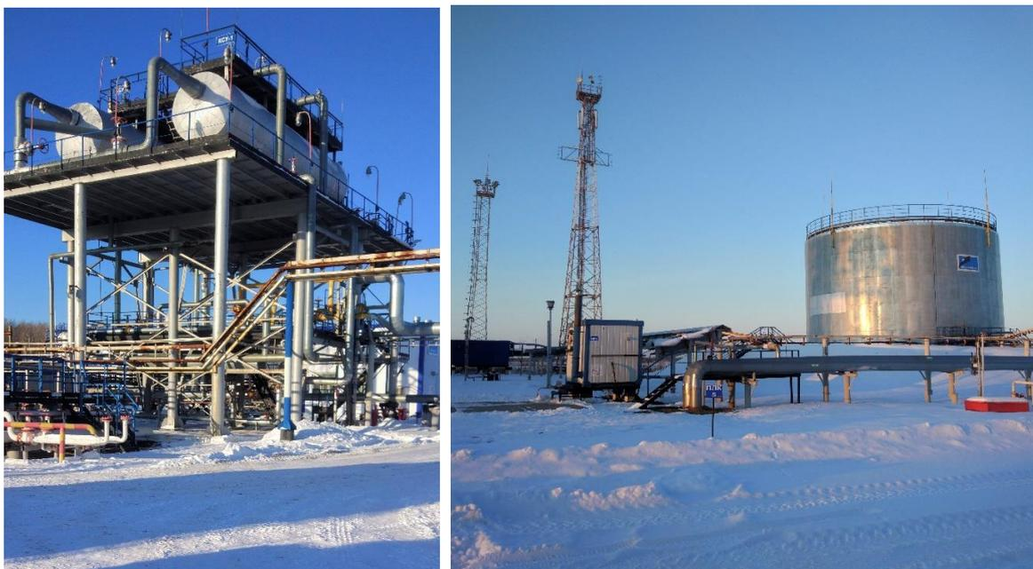
Рис. 1. Установка подготовки нефти и резервуар для её временного хранения на Верх-Тарском месторождении. Фотографии А.Ю. Калинина
